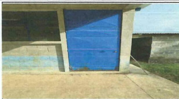
Foto 2: sustitución de puertas de aulas ya que se encuentra en mal estado
