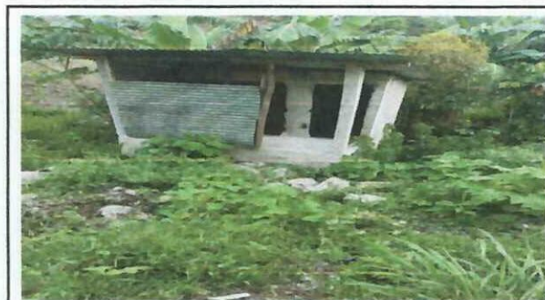
Foto 4: ampliación calle para el baño. Fundición de losa de piso del baño ya que está en mal estado
