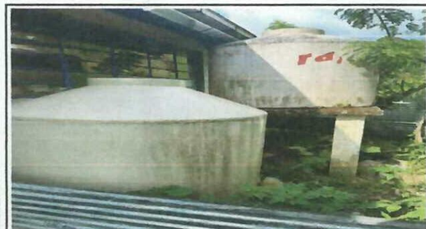
Foto 3: mejoramiento de la base de los tinacos y sus accesorios ya que se ha ido arruinando bajo la interperie
