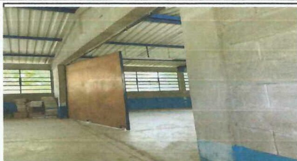
Foto1: sustituir la división anterior (de tabla a block) ya que la tabla que divide el aula está en mal estado
